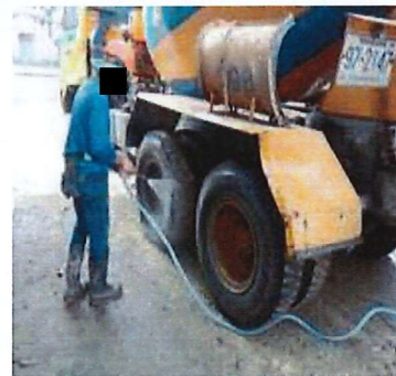
8. การล้างล้อรถบรรทุกที่เข้า-ออกพื้นที่โครงการ
